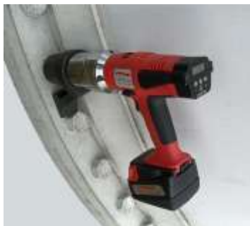
Łączenie śrubowe podstawy turbiny wiatrowej; ADS 75; M 30; 750 Nm
