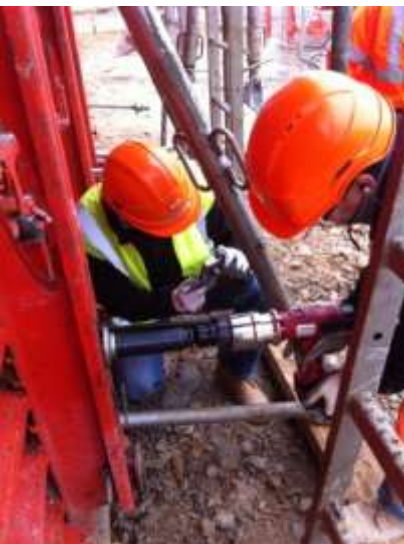
System montażu ściany betonowej z przedłużką i specjalnym ramieniem reakcyjnym; ADS 125; M 30
