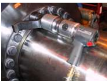
Połączenie tarczy skurczowej turbiny wiatrowej; PDS 250; M 30
